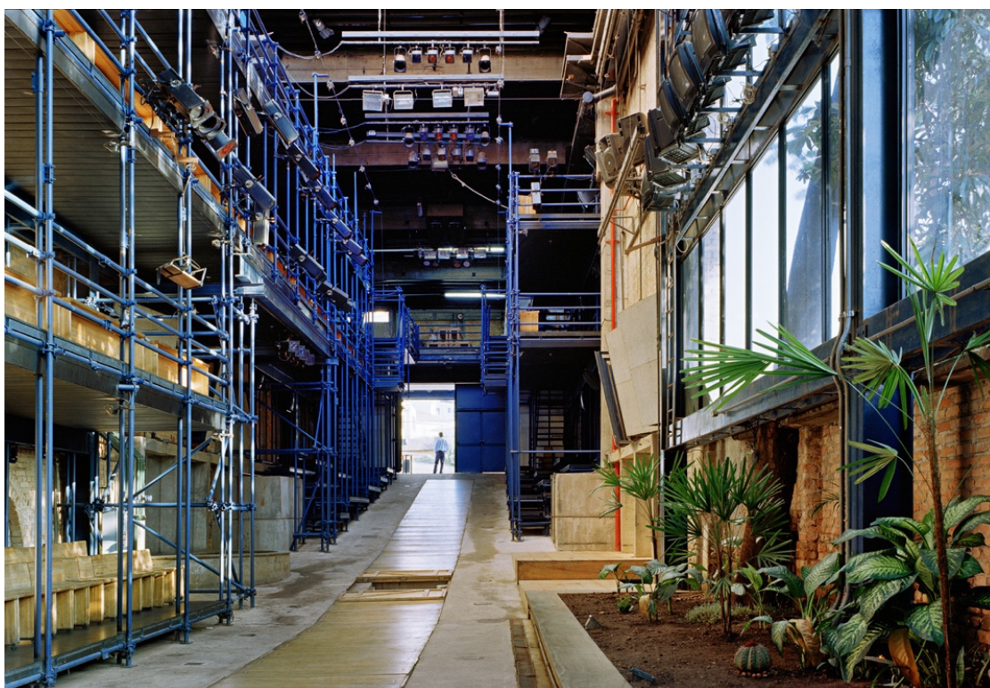
Figura 7 - Teatro Oficina, em São Paulo, projetado por Lina, 1984. Fonte: Pereira, 2017
