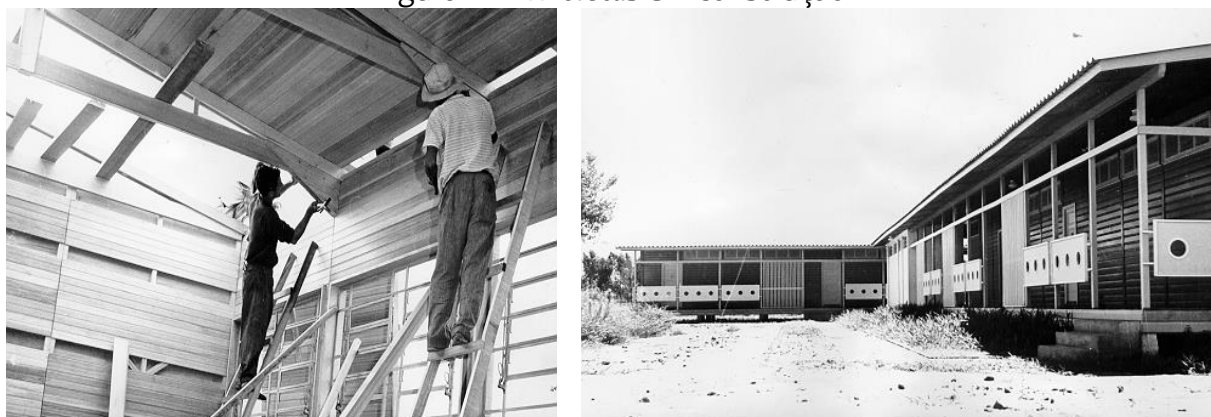
Figura 11 - Brizoleiras em construção
